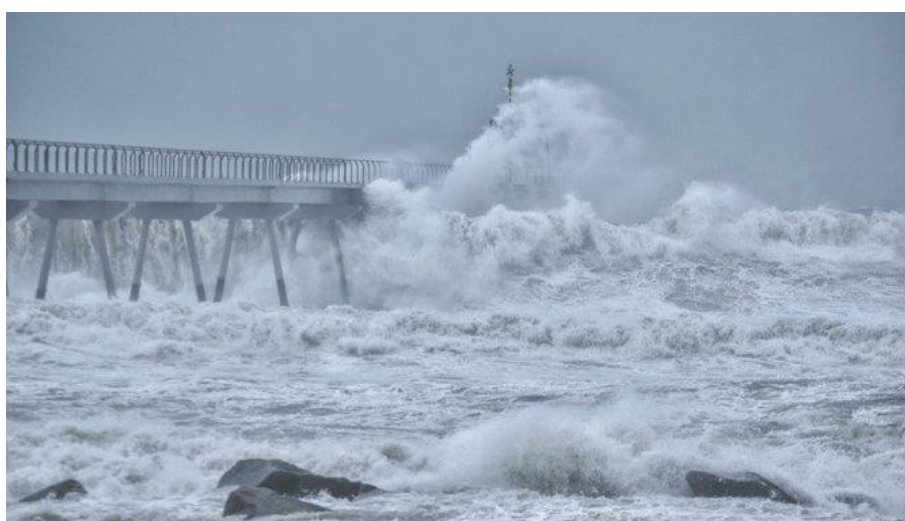
Afectació del temporal Glòria al pont del Petrolí de Badalona. Lluís pf.
