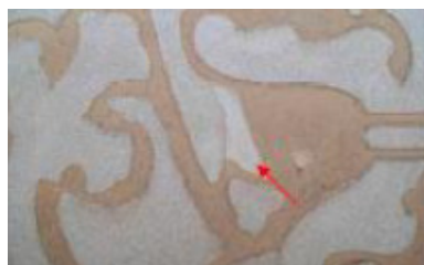
Fig. 55. Zona de pèrdua d'una placa d'esgrafiats. Font: Lévano, B (2010).
