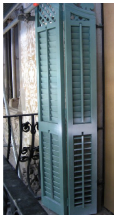
Fig. 87. Nova fusteria colocada. Font: Lévano, B (2010).
