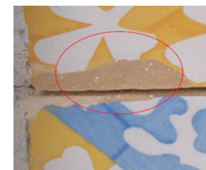
Fig. 81. Taques blanques en el morter de reintegració. Font: Lévano, B (2010).
