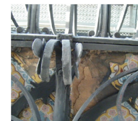
Fig. 84. Lesió ceràmica del balcó de la planta principal. Font: Lévano, B (2010).
