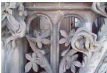
Fig. 63. Detall brutícia superficial. Font: Lévano, B (2010).
