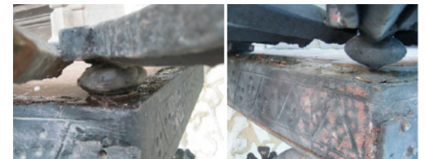
Fig. 95. Fotografies del abans i després de la restauració. Font: Lévano, B (2010).
