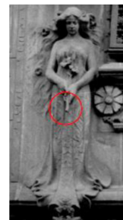
Fig. 70. Detall de la pèrdua de la part inferior del ram de la princesa. Data aproximada de la primera imatge 1900. Lévano, B (2010).
