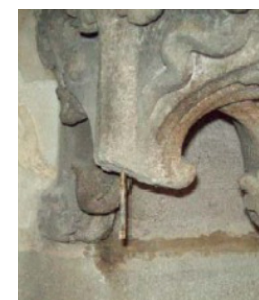
Fig. 69. Recolocació de les peces. Font: Lévano, B (2010).
