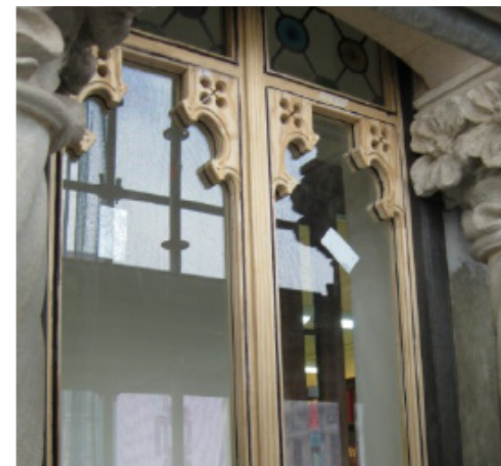
Fig. 91. Reposició de la carpinteria. Font: Lévano, B (2010).
