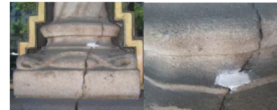
Fig. 93. Detall testimoni esquerda 26 de juny de 2008. Font: Lévano, B (2010).
