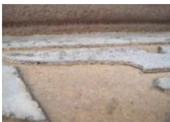
Fig. 54. Zona de descohesió d'una placa d'esgrafiats. Font: Lévano, B (2010).
