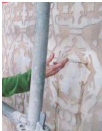
Fig. 51. Detall procés d'injecció Font: Lévano, B (2010).
