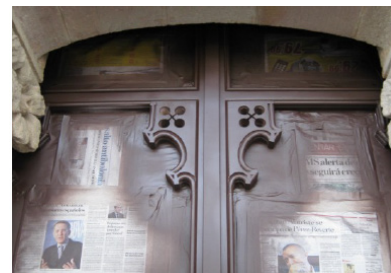
Fig. 89. Capa de pintura nova fusteria. Font: Lévano, B (2010).
