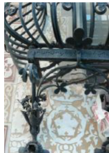
Fig. 77. Detall primera capa de pintura. Font: Lévano, B (2010).
