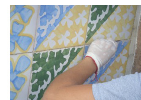
Fig. 82. Neteja juntes de la ceràmica. Font: Lévano, B (2010).
