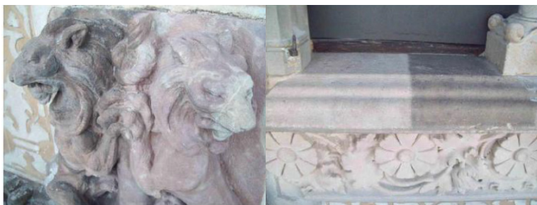
Fig. 65. Procés de neteja mecànica. Font: Lévano, B (2010).
