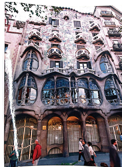
Fig. 111. Villanueva, X (1999). Imatge de l'estat de la façana. Extreta del Projecte de rehabilitació de la façana principal i terrat. (Exp N 133/99). Localitzat al Departament de Cultura de la Generalitat de Catalunya.
