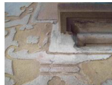
Fig. 56. Detall d'una esquerdada de l'estuc. Font: Lévano, B (2010).
