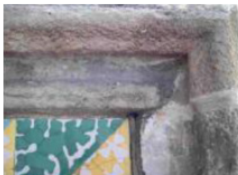
Fig. 64. Detall zona amb crostes negres. Font: Lévano, B (2010).
