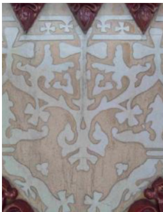
Fig. 50. Detall de l'estuc de nova execució. Font: Lévano, B (2010).
