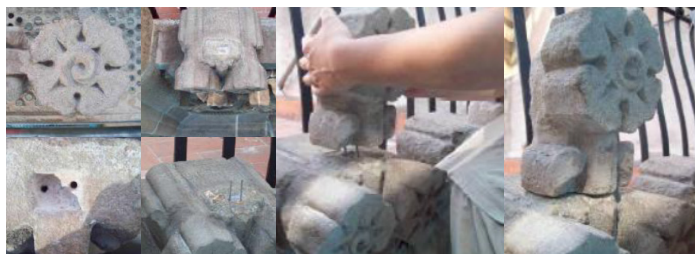
Fig. 66. Peça des'resa del conjunt. Procés de perforació i inserció de les ànimes d'acer per a la subjecció i colocació de la peça. Font Lévano, B (2010).
